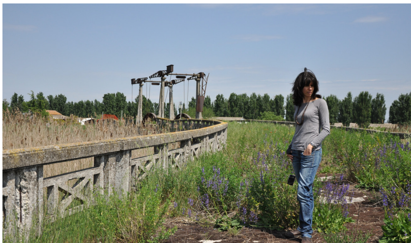
Figura 1. Ponte dei Pesi, Cona-Cavarzere (Ve). Tra manufatti della bonifica durante un'escursione di studio nel Basso Veneto nel 2012 (fotografia dell'autore).
