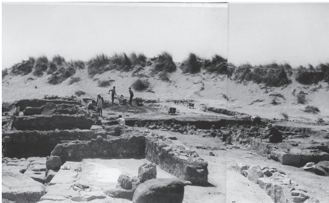
Fig. 7 – Fotografia scattata in data 25 agosto 1962, ritraente i lavori di scavo nel tofet, da nord (da Archivio famiglia Pesce)
