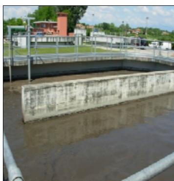
Figura 26: Ispessitore statico da cui è stato prelevato il fango biologico utilizzato nella sperimentazione
