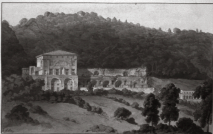
Vue générale de la Villa
