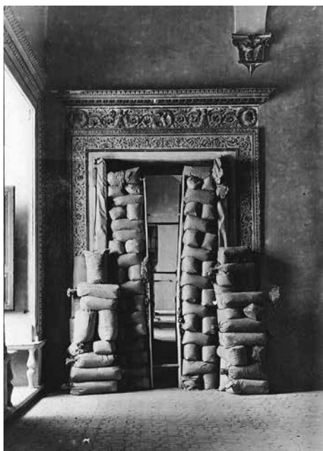
7. Palazzo ducale, Urbino, particolare della protezione alla Porta della Sala degli Angeli, Archivio fotografico della Soprintendenza per i Beni Ambientali e Architettonici delle Marche
