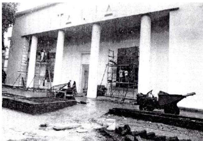
L'immagine, pubblicata su Il Gazzettino di Venezia mostra lo stato dei lavori al padiglione Italia poco prima dell'inaugurazione.
