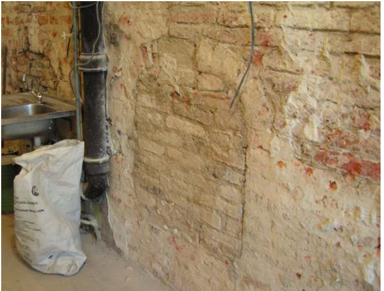
Fig. 19. Tracce delle bocche per la carica delle stufe rinvenute nel corridoio orientale del pian terreno durante i restauri del 2004, fotografia (Per gentile concessione di Andrej A. Mel'nikov, MAE RAN)
