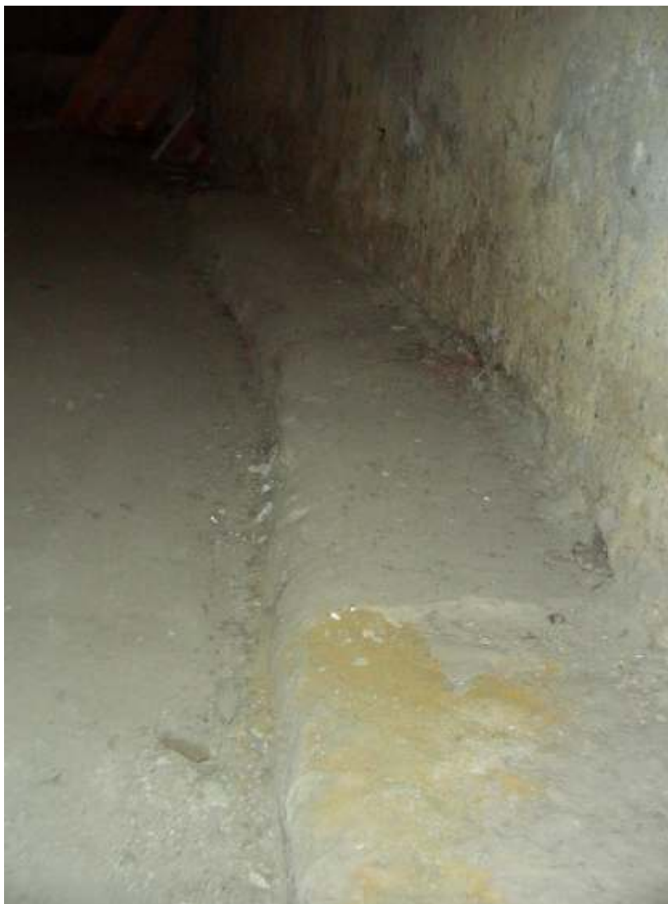
| Fig. 14. Le lastre di pietra delle fondamenta della Kunstkamera nel seminterrato, fotografia (Guarneri 2008)
