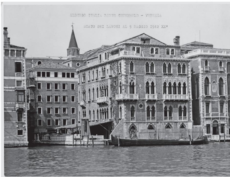
3. Il cantiere di ristrutturazione e ampliamento dell'hotel Bauer il 5 maggio 1942 (Venezia, Dipartimento di Filosofia e Beni Culturali, Archivio e Fototeca Antonio Morassi, unità V XXIII, inv. V4242).
