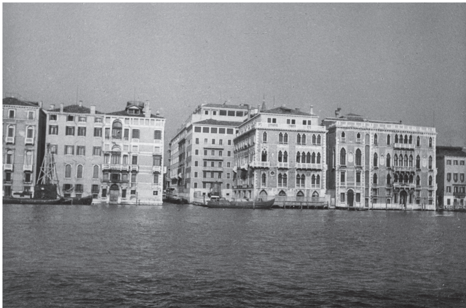
4. Il cantiere di ristrutturazione e ampliamento dell'hotel Bauer nell'agosto 1948 (Venezia, Dipartimento di Filosofia e Beni Culturali, Archivio e Fototeca Antonio Morassi, unità V XXIII, inv. V4244).
