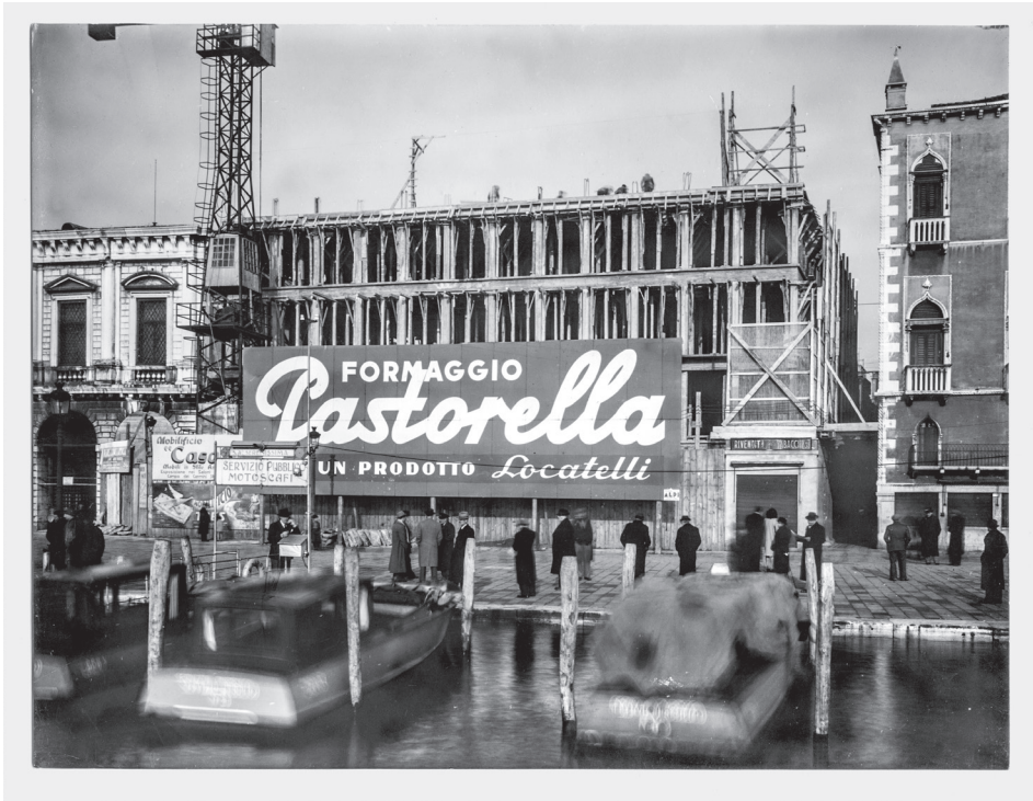
7. Il cantiere di costruzione del 'Danielino' (Venezia, Dipartimento di Filosofia e Beni Culturali, Archivio e Fototeca Antonio Morassi, unità V XXIII, inv. V4239).
