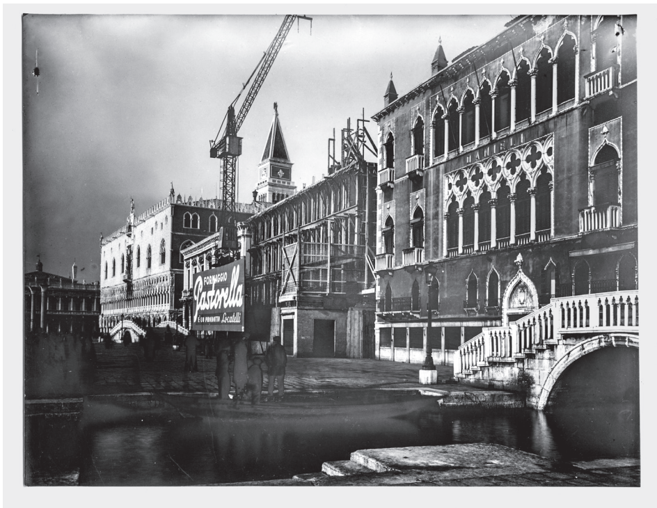
6. Il cantiere di costruzione del 'Danielino' (Venezia, Dipartimento di Filosofia e Beni Culturali, Archivio e Fototeca Antonio Morassi, unità V XXIII, inv. V4238).
