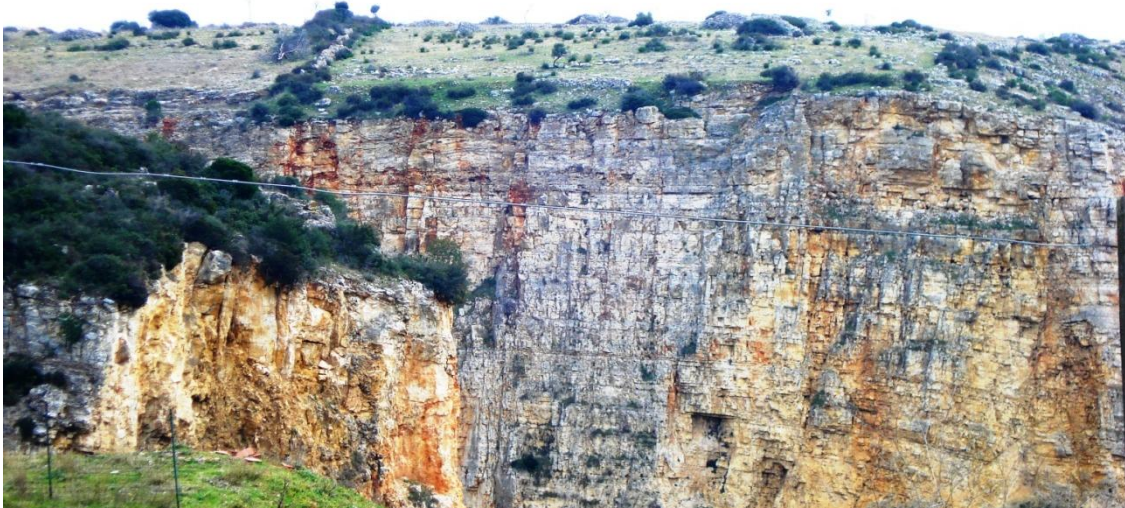
Fig. 1. Veduta della Gravina di Ginosa (TA). (Foto Autore).
