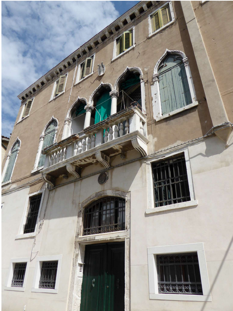
FIGURA 1 – Palazzo Arrigoni (Venezia, Cannaregio 3335-3336, Fondamenta della Sensa)
