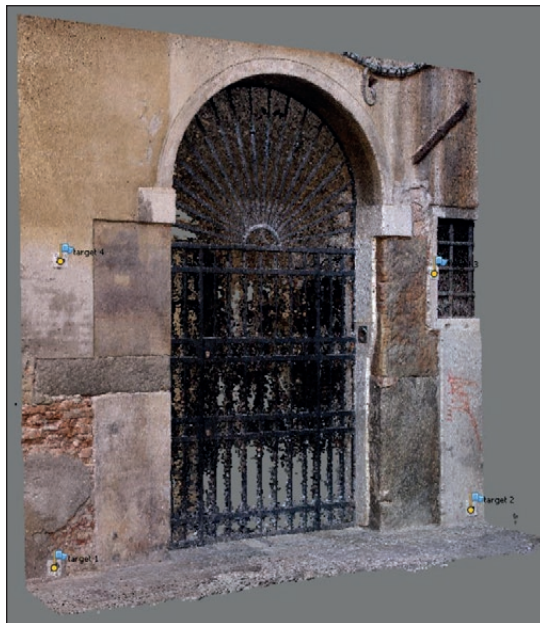
Fig. 6 – Nuvola di punti densa del portale in Corte dei Pali già Testori, Cannaregio 3837, Venezia, e target acquisiti tramite Leica Disto S910 (E. Delpozzi).
