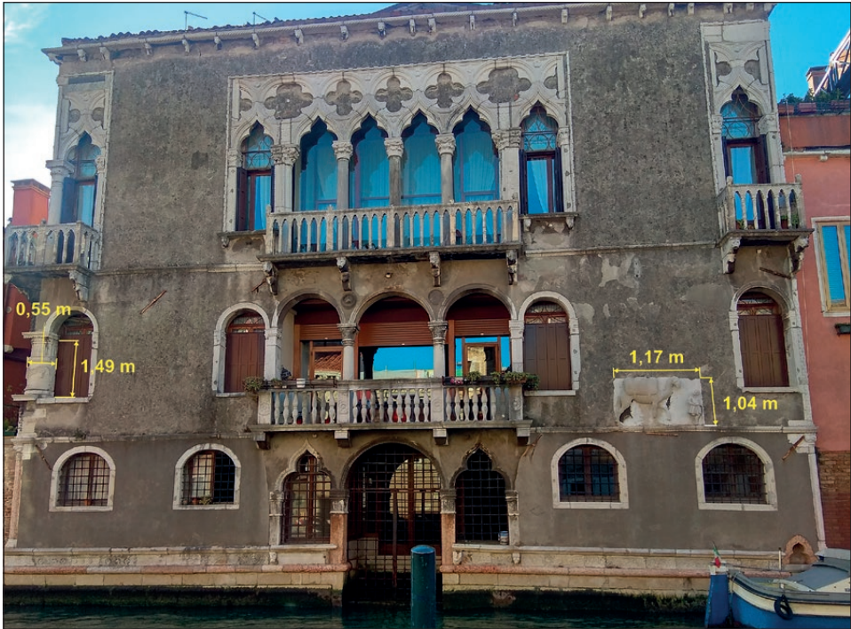
Fig. 4 – Processo di misurazione dell'ara di età ellenistica e del rilievo con cammello del XIV secolo in opera nella facciata di Palazzo Mastelli, Cannaregio, Venezia (E. Delpozzi, M. Pilutti Namer).
