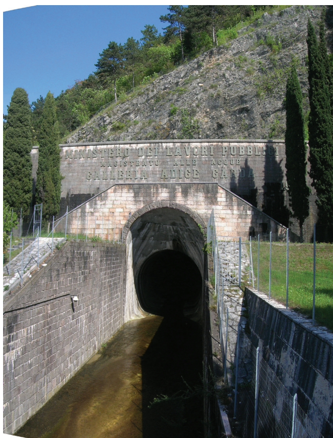
Fig. 2 - Lo sbocco della galleria a Nago-Torbole.
