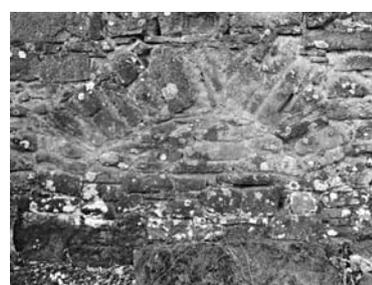
FIG. 6. Le Mogne: apertura tamponata nel muraglione settentrionale.
