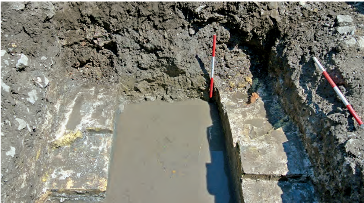
Fig. 46. Saggio 1 – Settore F: dettaglio del primo condotto ellittico visto da nord-ovest, di cui si vedono le due spallette in sesquipedali legati da malta (la spalletta sud, US 177 e quella nord, US 178) (fotografia di Valeria Grazioli).
