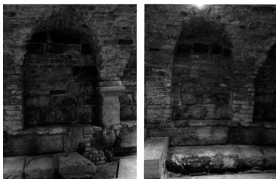
Fig. 2 - Murature alto-medievali della Cripta della Basilica di San Marco, interamente realizzate con materiali di spoglio antichi. Foto dell'Autore.
