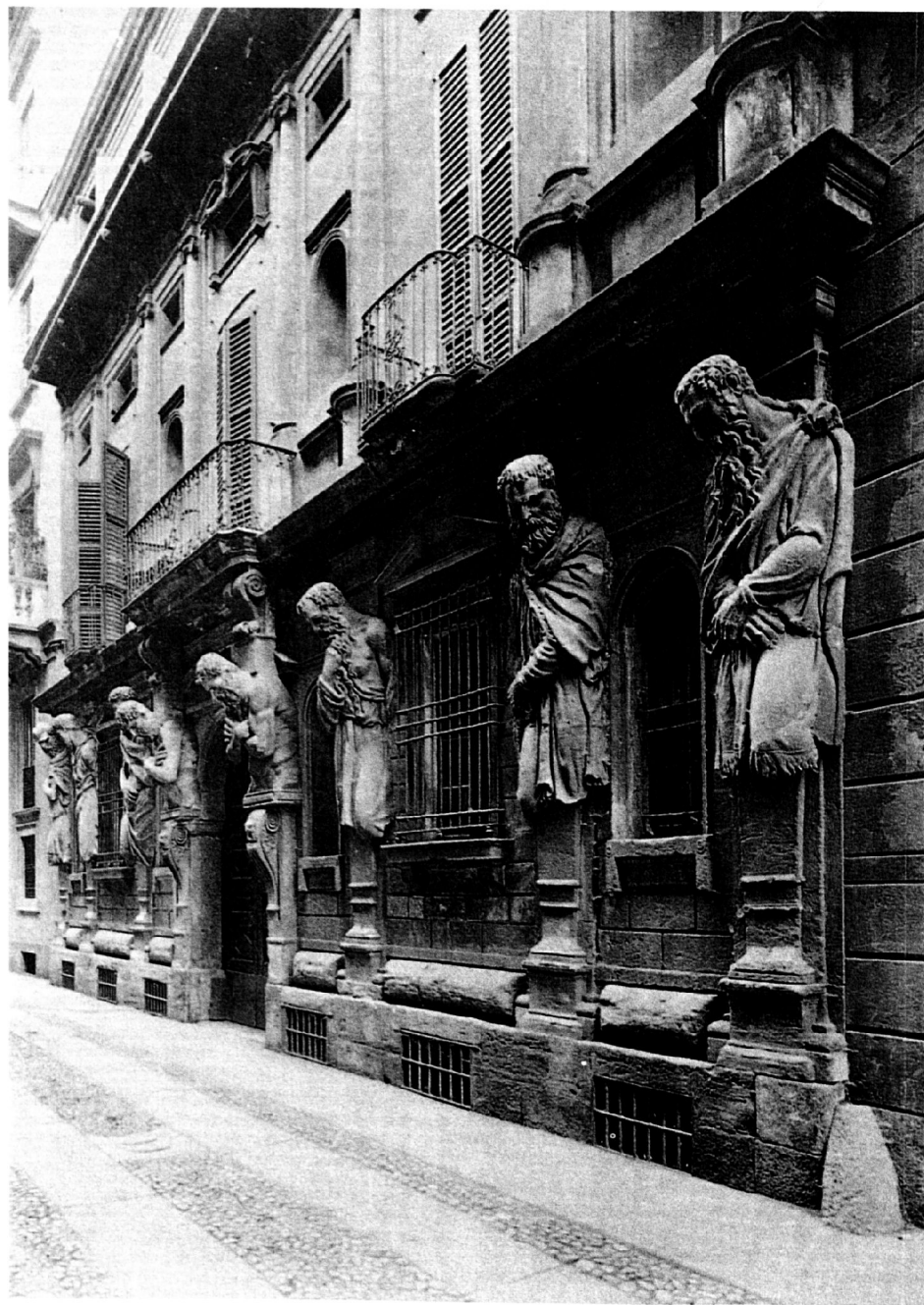
19. Leone Leoni (?) e Antonio Abbondio da Ascona: Facciata della 'Casa degli Omenoni' (1562-66). Milano, Via degli Omenoni.
