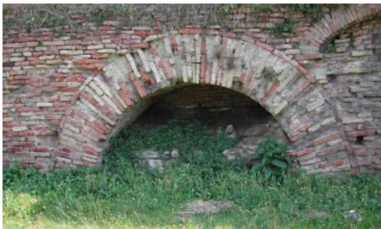
Fig. 5. Ravenna, tratto di mura ad ovest di Porta Serrata (ricognizioni urbane 2002), foto dell'A.
