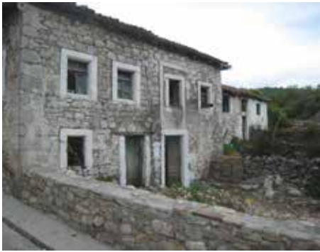
Figure 4-6. Ricostruzione in stile finanziata con i fondi WB all'interno del castello di Drisht e, di contro, la totale ruderizzazione degli edifici storici
