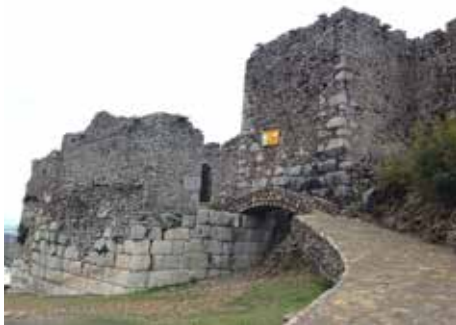
Figura 8. Castello di Lezha, il ponte di accesso di nuova realizzazione
