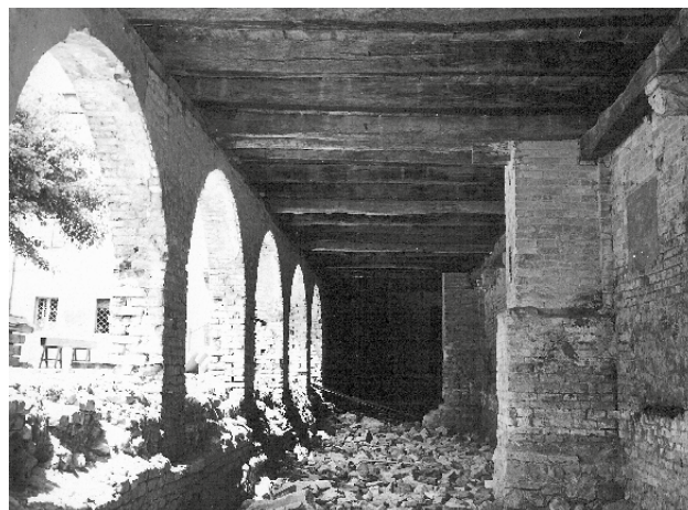
fig. 17 – Il lato settentrionale del chiostro, addossato all'abbazia, in occasione degli interventi di restauro degli anni '60 del XX secolo.
