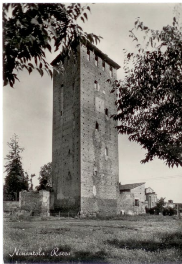
fig. 29 – Nonantola, la Torre dei Bolognesi.
