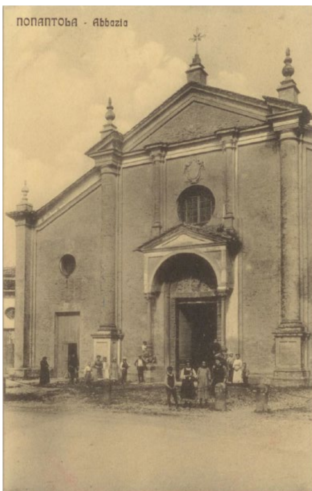
fig. 7 – Facciata della chiesa abbaziale in una foto degli inizi del XX secolo.
