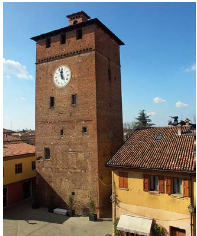
fig. 27 – Nonantola, la Torre dei Modenesi.
