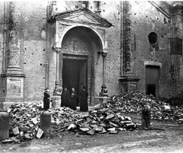
fig. 15 – Nonantola, foto della facciata della chiesa abbaziale durante i restauri dei primi anni del ’900.
