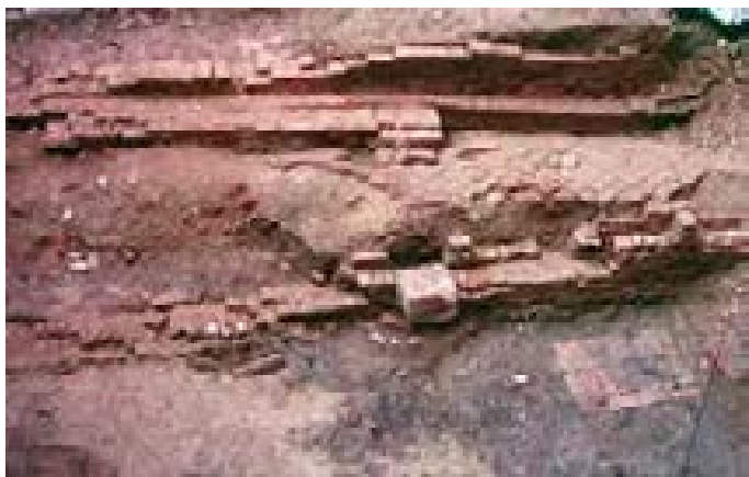
5. Bologna, Palazzo Pepoli. Strutture duecentesche precedenti la fondazione del palazzo
