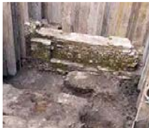
3. Ravenna, Piazza Anita Garibaldi. La struttura muraria altomedievale
