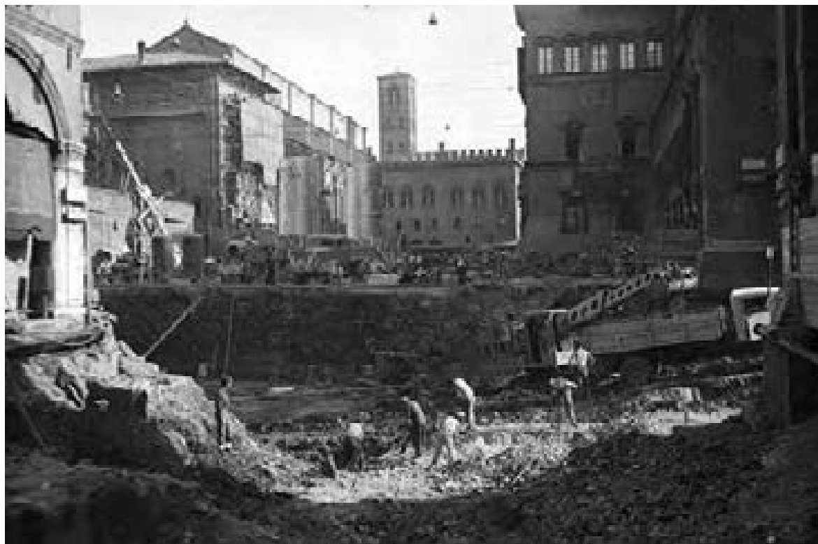
1. Bologna (1959), incrocio tra Via Indipendenza e Via Ugo Bassi-Piazza del Nettuno. Lavori di sbancamento per la realizzazione del sottopasso (Archivio SABAP BO-MO-RE-FE neg. 13550)
