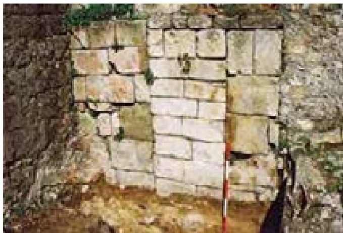
8. Canossa (RE). Prospetto sud della cortina muraria entro il secondo ambiente; ben visibile la porta tamponata
