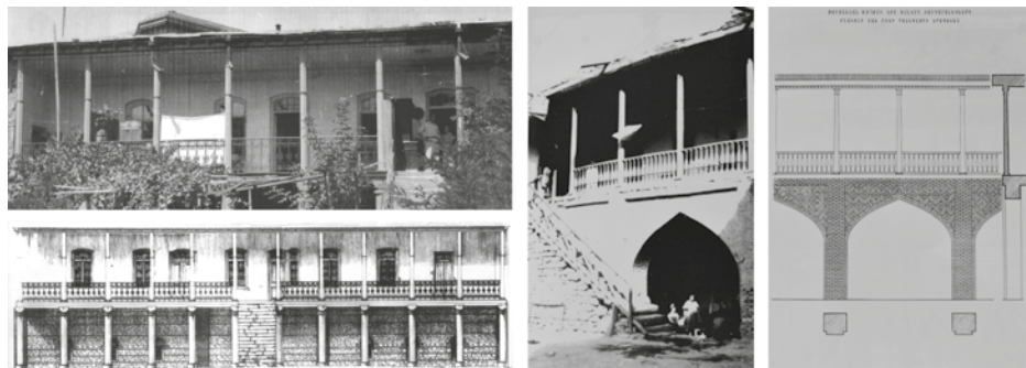
5. La veranda di Casa Janibekians in via Terian (foto e disegno); la veranda di Casa Khudabashians in via Yeznik Koghbatsi (foto e disegno).
