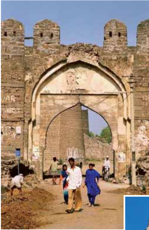
Fig. 4. Puerta occidental del fuerte de Gulbarga.
