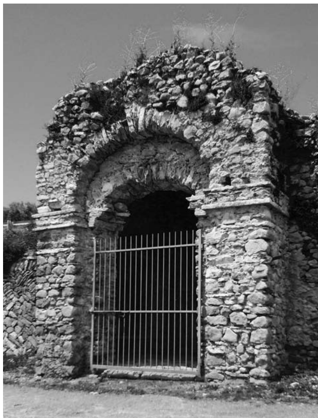
Villa Della Torre a Fumane, Grotta superiore o bucintoro.
