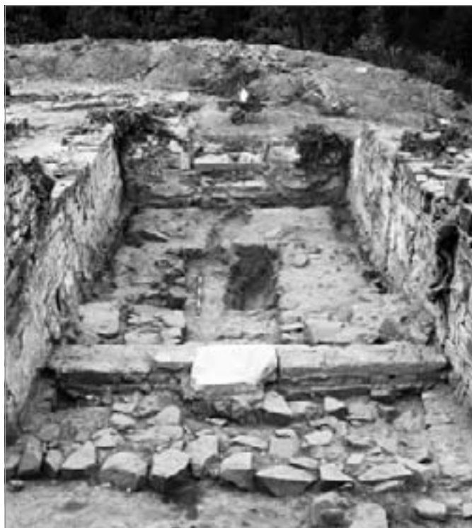
fig. 35 – Veduta generale della navata e delle fosse di fondazione dei nuovi muri perimetrali.
