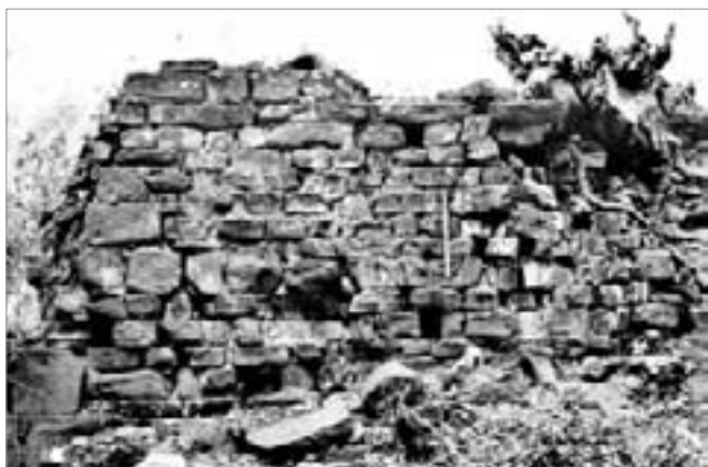
fig. 95 – Perimetrale orientale della torre.
