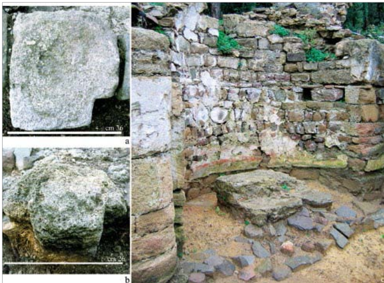
fig. 74 – San Quirico di Populonia (a-b, conci sagomati di lesena pertinenti l'abside centrale; c, emiciclo abside meridionale e basamento dell'altare).
