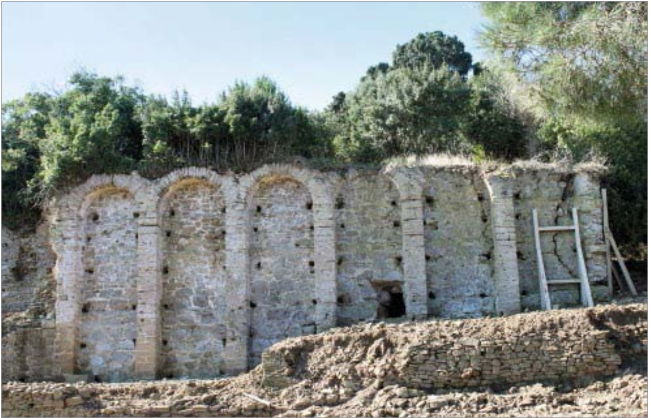
fig. 25 – Poggio del Telegrafo. Le sostruzioni del complesso delle Logge.
