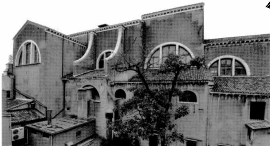
Fig. 42. Venezia, chiesa degli Scalzi, esterno, fronte est
