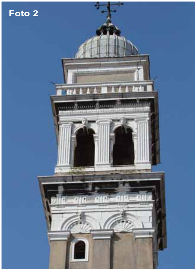
Foto 2 - La cella campanaria prima del restauro
