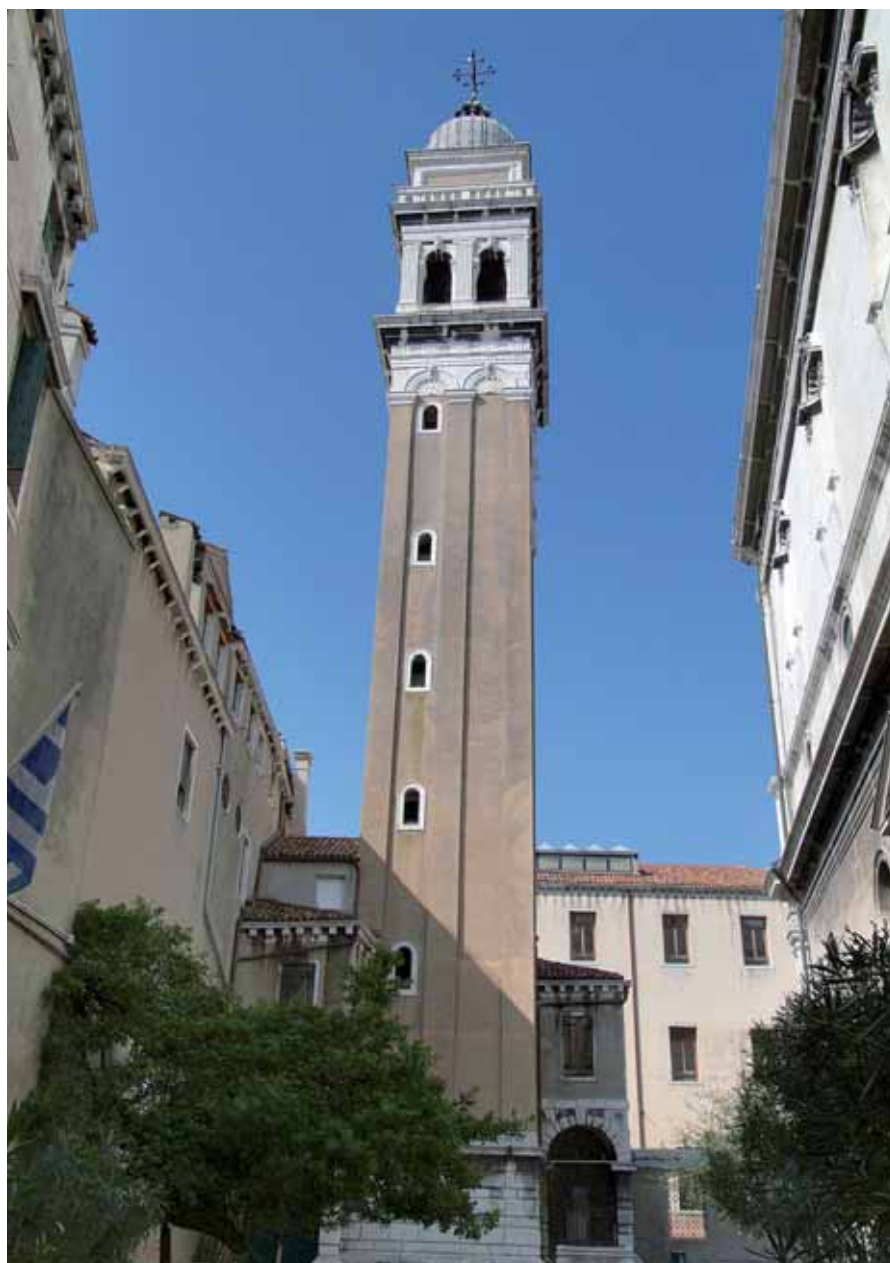
Foto 1 - Il campanile prima del restauro
