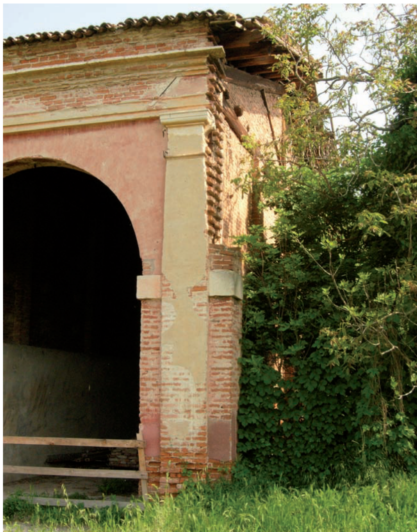
[Fig. 17] L'ultima arcata delle barchesse della Cucca, con ammorsature.
