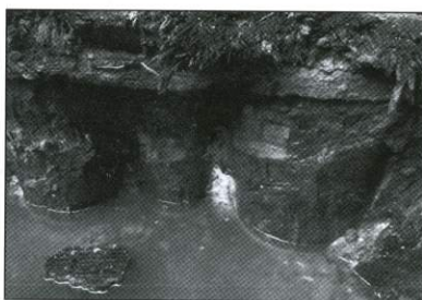
Figura 4: particolare palificazione e zatterone- Rio San Martino
