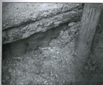
Figura 3: particolare palificazione e zatterone-Rio delle Acque Dolci
