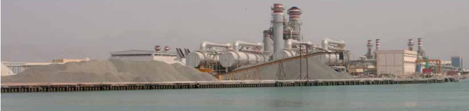
Figura 7 - Impianto di dissalazione negli Emirati Arabi Uniti (Rif. Web n. 8).
