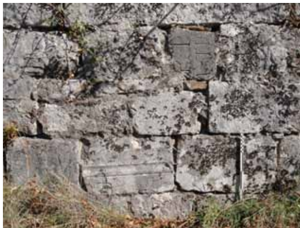
Fig. 19 - Opera muraria con materiale di spoglio, perimetrale interno dell'edificio cruciforme Slika 19 - Zidarski radovi i ponovo upotrijebljeni materijal, područje unutar objekta u obliku krsta
