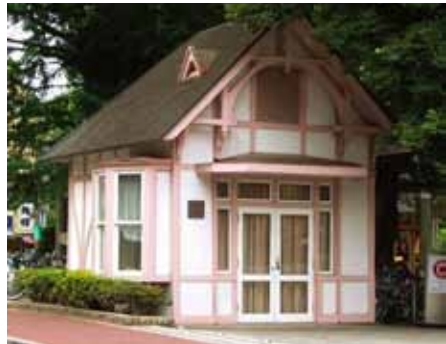
L'ex alloggio per stallieri della residenza di Ōkuma (Ōkumatei batei koya, 1882 ca.).
