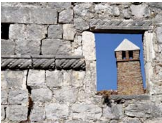
fig. 5.23a-b – Cornici marcapiano reimpiegate con diversa destinazione d'uso nel prospetto sud est dell'edificio 136.
