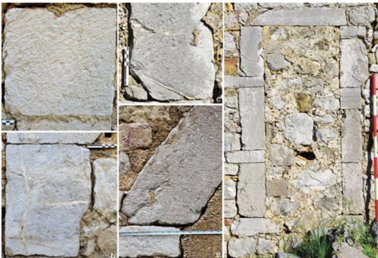
fig. 5.32 – Litotecnica e tracce di strumenti a lama dentata nelle aperture degli edifici 144 (a-b), 57 (c-d) e nei conci dell'arco della porta (206) di accesso al suburbio (e).
