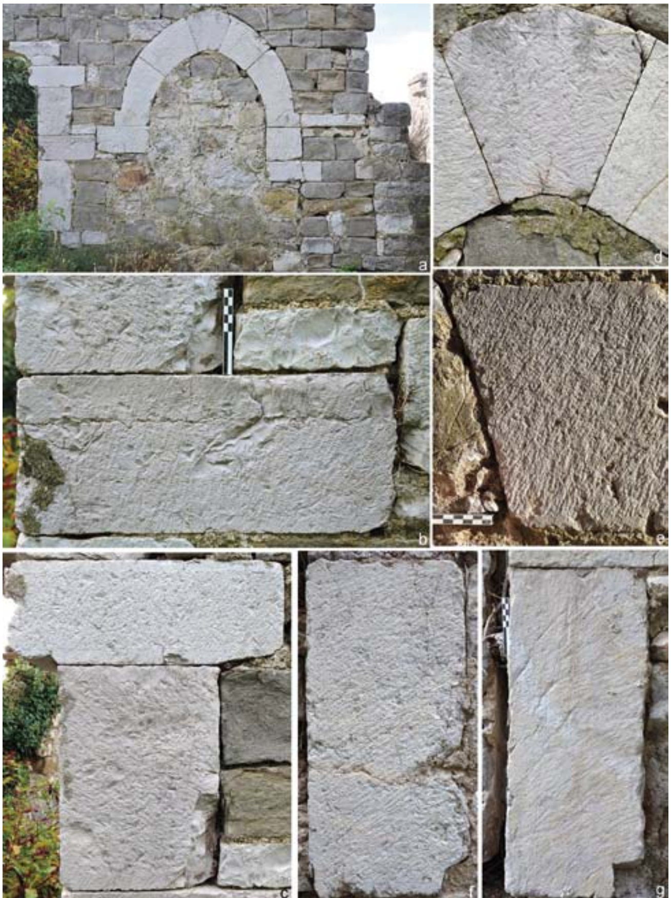
fig. 5.31 – Litotecnica e tracce di strumenti a lama piana e dentata nelle aperture degli edifici 136b (a-d) e 136 (e-g).
