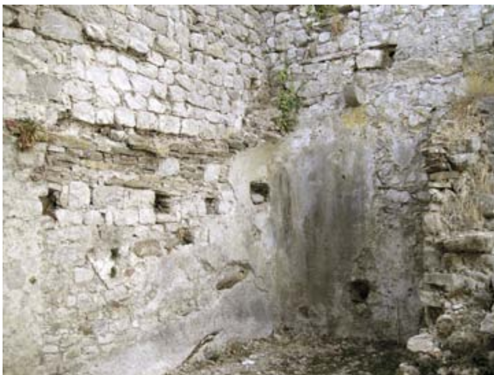
fig. 4.1 – Stari Bar, UTCF 153, resti dell'intonaco di rivestimento di ambiente originariamente voltato a botte (cisterna?).
