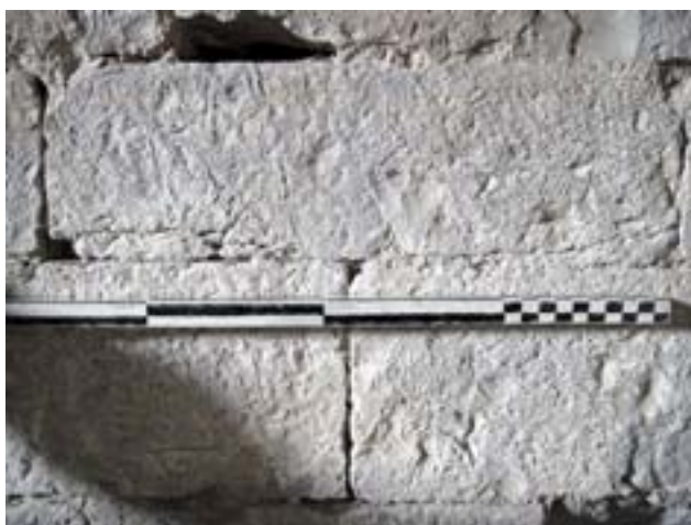
fig. 5.34 – Tracce di strumento a lama dentata a denti piani, paramento residuale dalla chiesa di S. Giorgio.
