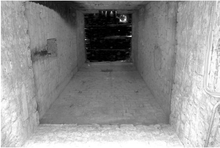
Tav. 3 - Verona, S. Giorgio in Braida, murature interne della torre campanaria romanica (terzo-quarto decennio del sec. XII).
