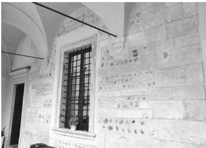
Tav. 5 - Verona, S. Giorgio in Braida, chiostro, porzione muraria dell'ala orientale (terzo-quarto decennio del sec. XII).
