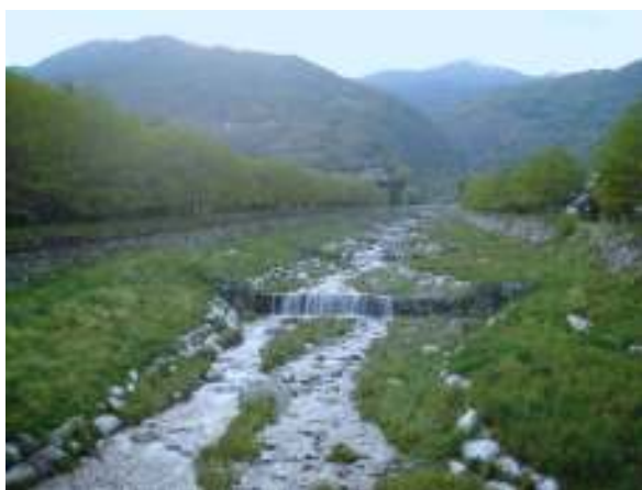
Fig. 4.42 - Tratto LAR007 (nel 2008), fasce con copertura erbacea non igrofila.
