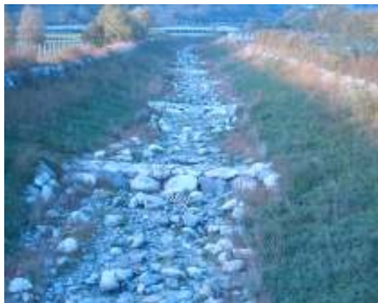
Fig. 4.78 - Tratto CEG003, 12 ottobre 2008.
