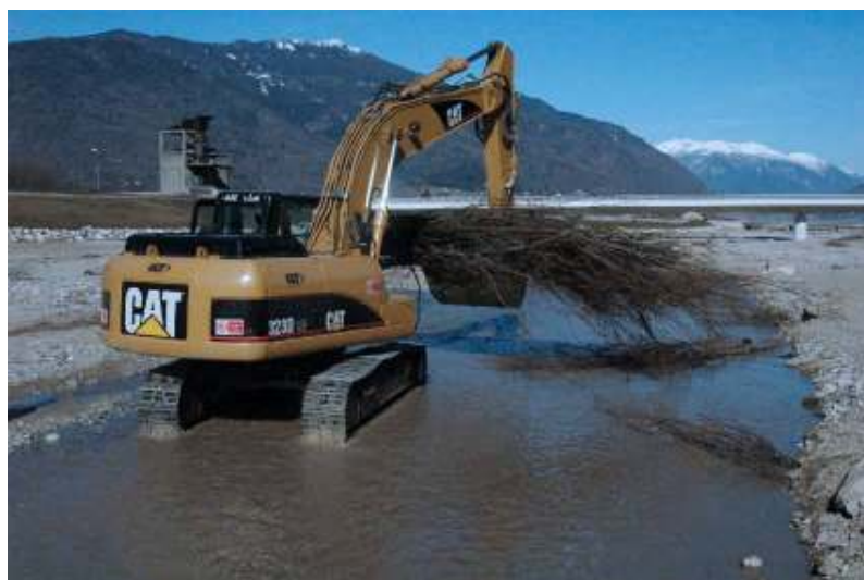
Fig. 4.24 – Lavori di riqualificazione sul torrente Centa (marzo 2009 – foto Paolo Negri)
