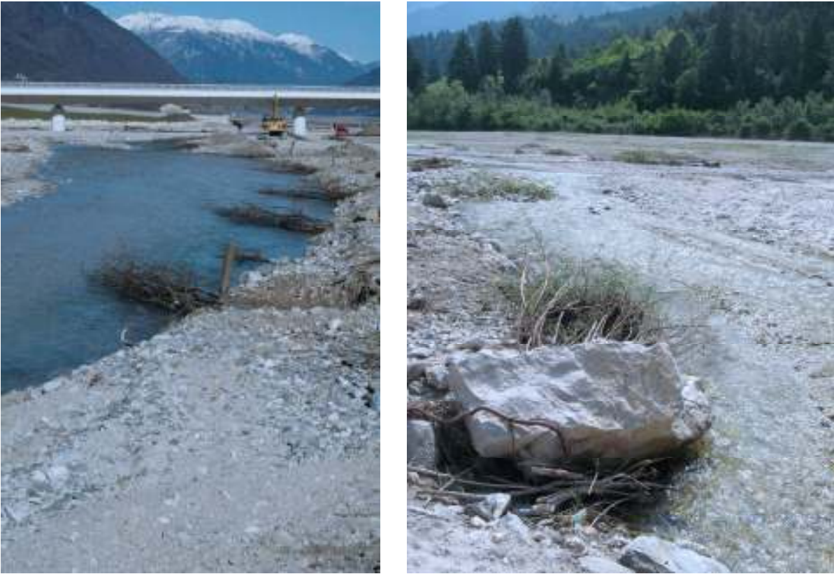
Fig. 4.26 – Fascinate disposte sulla sponda in erosione: marzo 2009 (foto Paolo Negri) e maggio 2009
