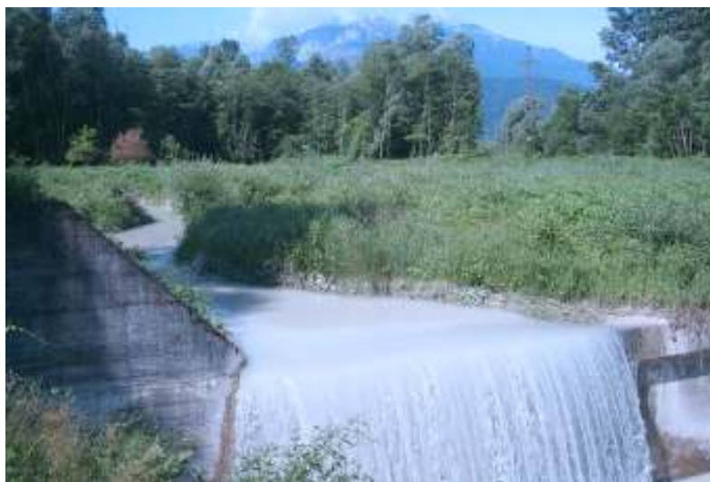
Fig. 4.22 – Briglia tradizionale in cemento al termine del tratto CEN003.
