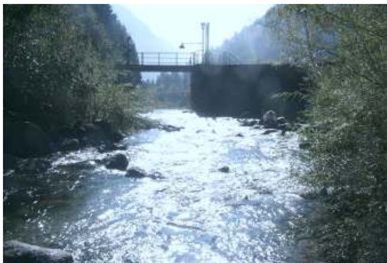
Fig. 4.92 - Opera di presa dell'acqua del torrente Maso all'inizio del tratto MAS014.
