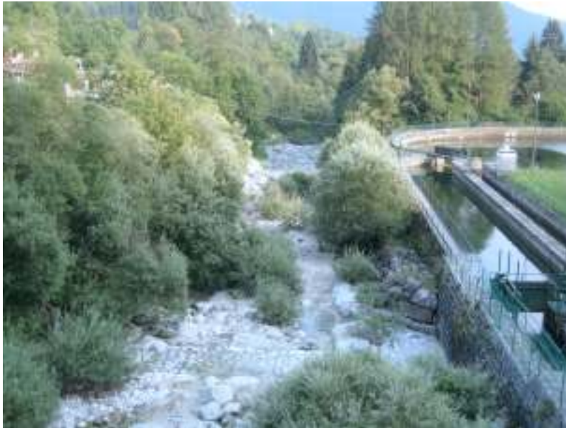
Fig.4.121 – Tratto GRI014 a valle di una derivazione di tutta la portata del torrente.
