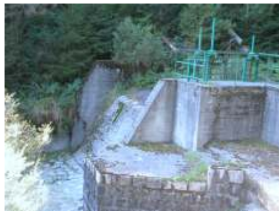
Fig. 4.109 - Opera di presa dell'acqua del torrente Chieppena all'inizio del tratto CHI014.
