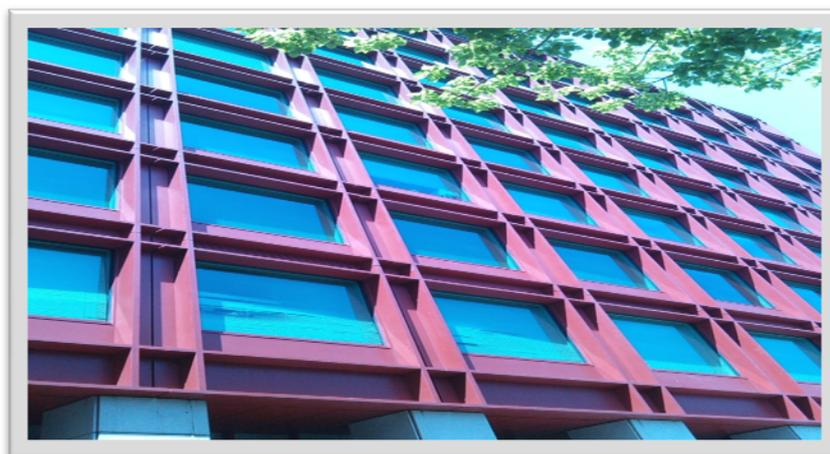
*Foto 4. Particolare dell'intelaiatura metallica della facciata dell'IIC.*
