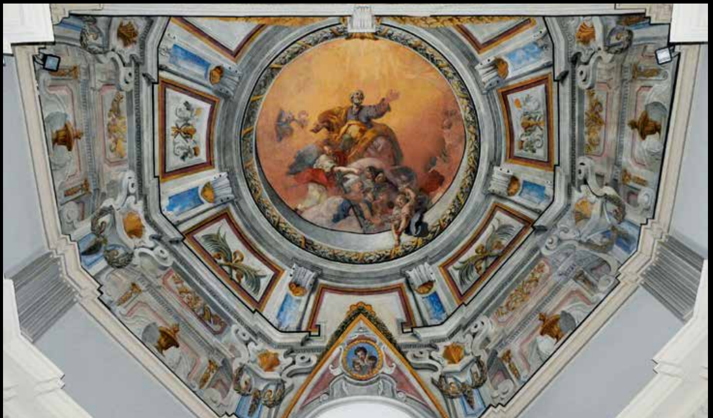
Volta del catino absidale dopo il restauro
