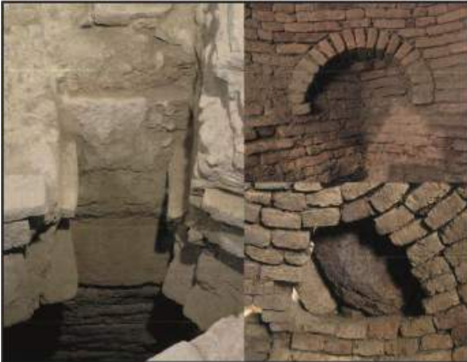
Fig. 2. Il vano ipogeo. In senso orario partendo da sinistra: la caditoia con scivolo, gli archi, la caditoia coperta dal masso.
