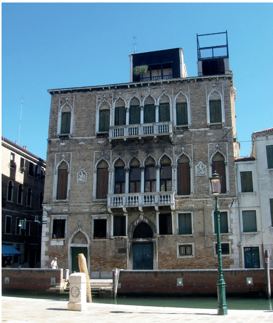
Fig. 1. Facciata del palazzo Nani di San Trovaso a Venezia.
