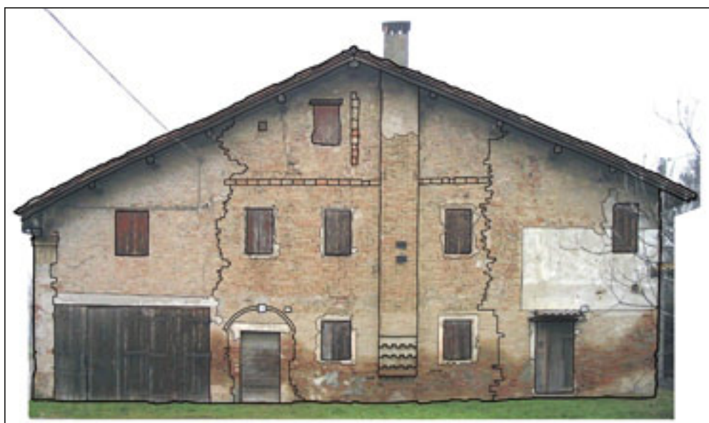
fig. 17 – Casa Limpido, lato Sud.
