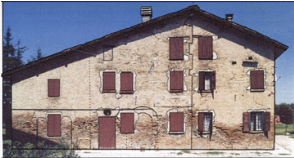
fig. 21 – Casa Mosto, lato sud.
