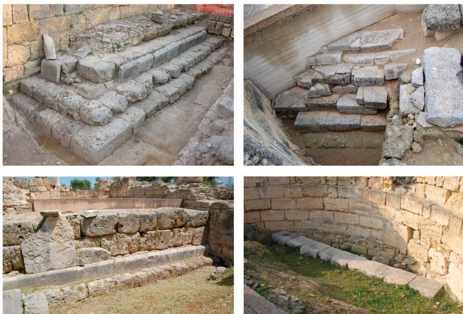
Fig. 9. Canosa, loc. S. Leucio. Strutture superstiti del podio aggiunto al tempio (foto autore).
