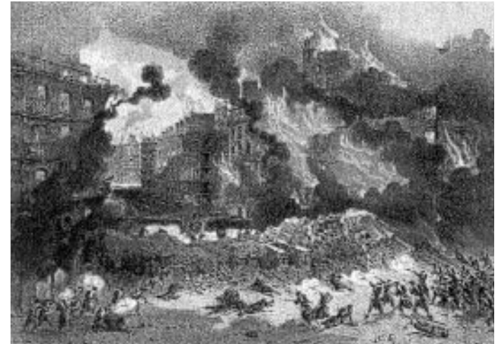
14. En se repliant vers l'est de Paris, les "Communards" adoptèrent la tactique des incendies: le Palais des Tuileries fut incendié pendant la "semaine sanglante" du 21 au 27 mai 1871. Il sera rasé en 1882 et remplacé par un jardin, in Paris, Guide Gallimard .
