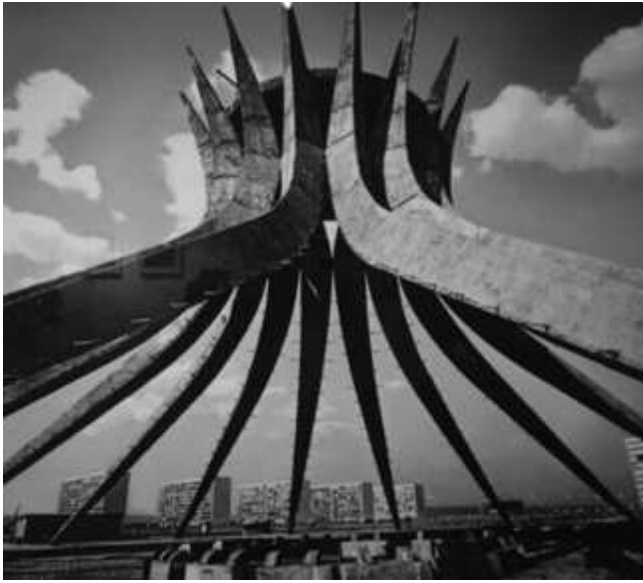
FIG. 140 – CATEDRAL DE BRASÍLIA, LE COLLANE DI BASE COSTRUTTE TRA 1959-1960.
