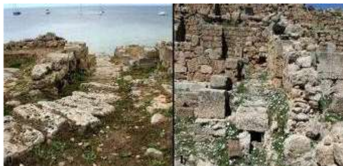
Fig. 148. Vista da Ovest del tratto di cloaca a Nord delle Terme n. 2 (a) e vista da Est del tratto del condotto fognario posto tra i complessi nn. 11 e 15 (b) (foto M. Marano).
