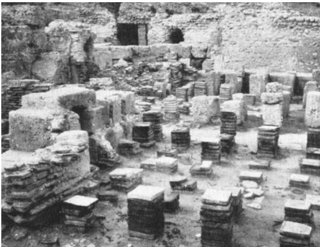
Fig. 19. Vista di un tratto del calidarium (n. 12) delle Terme n. 1 (PESCE 1958, tav. XIV fig. 27).
