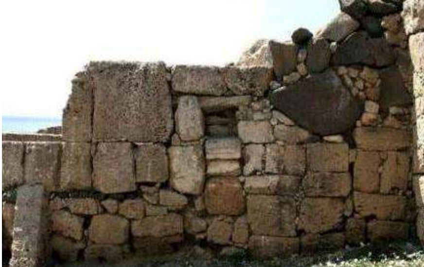
Fig. 239. Vista da Nord di un tratto del muro meridionale (USM 161-163) del vano orientale dell'edificio n. VI (foto M. Marano).
