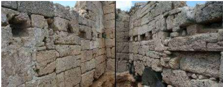
Fig. 108. Vista degli intacchi per travi nelle pareti meridionale (a) e settentrionale (b) del complesso n. 19 (foto M. Marano).
