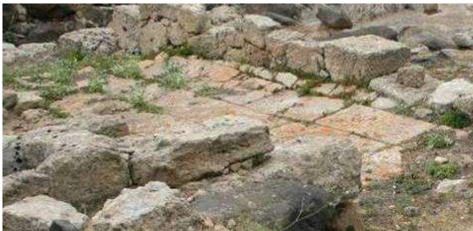
Fig. 75. Vista da Sud-Ovest del pavimento a bipedali dell'edificio n. 63 (foto M. Marano).
