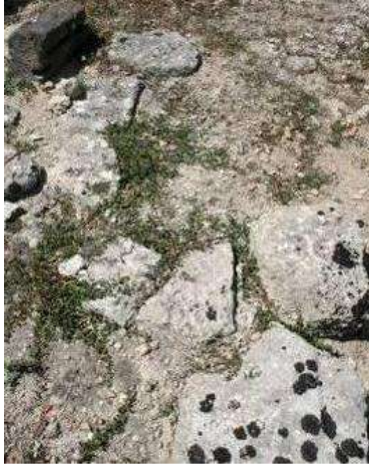
Fig. 237. Vista da Est del bordo superiore orientale della cisterna ubicata nell'edificio n. VI (foto M. Marano).
