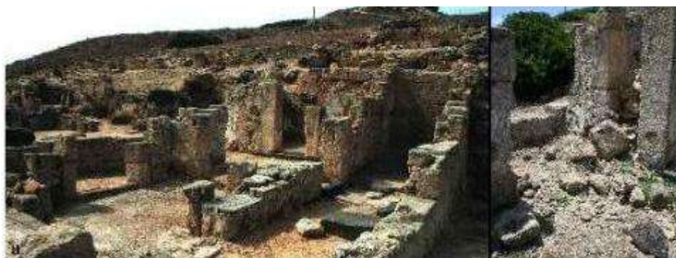
Fig. 142. Crollo di un tratto del muro orientale del vano di fondo dell'edificio n. 20 (b), non ancora attestato agli inizi degli anni Novanta del secolo scorso (a) (a: DESOGUS 1991, p. 65; b: foto M. Marano).
