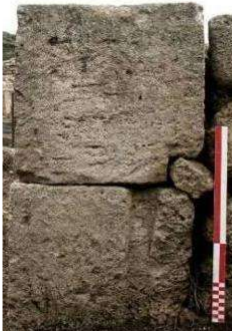
Fig. 225. Vista da Ovest dell'USM 102 del vano sud-occidentale dell'edificio n. IV (foto M. Marano).
