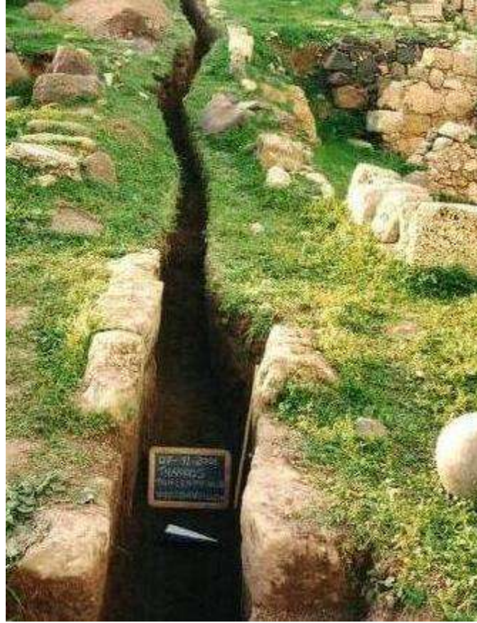
Fig. 131. Vista della trincea scavata nei pressi di Via delle Cisterne (ASSACO-Faldone “Cabras. Tharros. Documentazione archeologica di scavo. Lavori impianto videosorveglianza e antintrusione. Impresa O. Murgia” foto 18).
