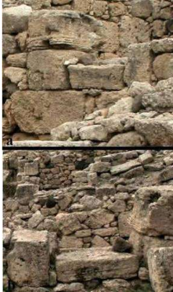
Fig. 227. Vista da Sud-Est (a) e da Nord (b) della finestra nell'USM 93 del vano nord-occidentale dell'edificio n. IV (foto M. Marano).
