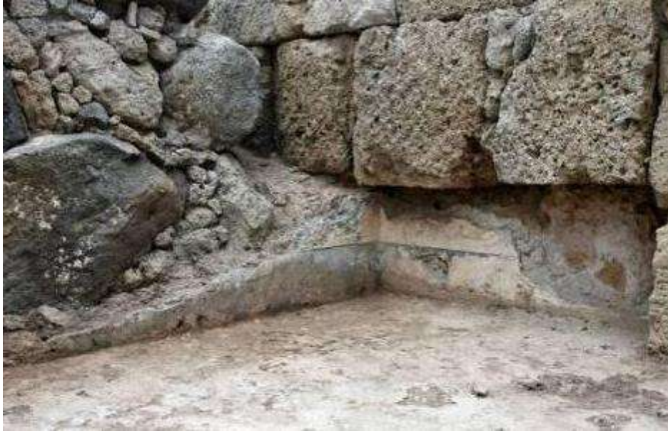
Fig. 176. Vista del tratto di muro con tracce di decorazione, nell'edificio n. 58 (foto M Marano).
