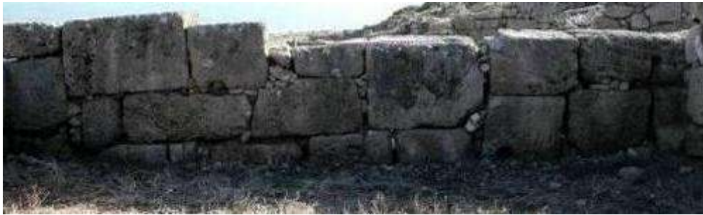
Fig. 219. Vista da Nord dell'USM 46 del vano sud-orientale dell'edificio n. 5 (foto M. Marano).
