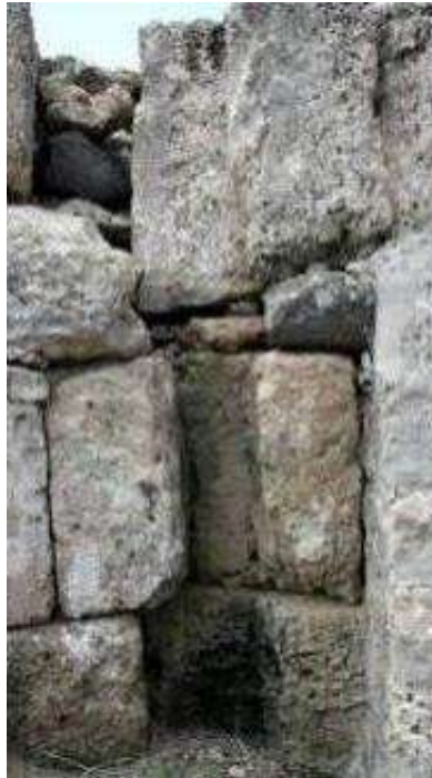
Fig. 238. Vista da Nord dello scasso per la tubazione realizzato nel muro meridionale del vano orientale dell'edificio n. VI (foto M. Marano).
