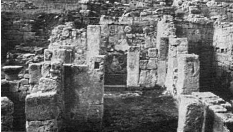
Fig. 265. Vista da Est della parte meridionale del complesso n. XV, al tempo degli scavi (PESCE 1966b, fig. 40, ritagliata).
