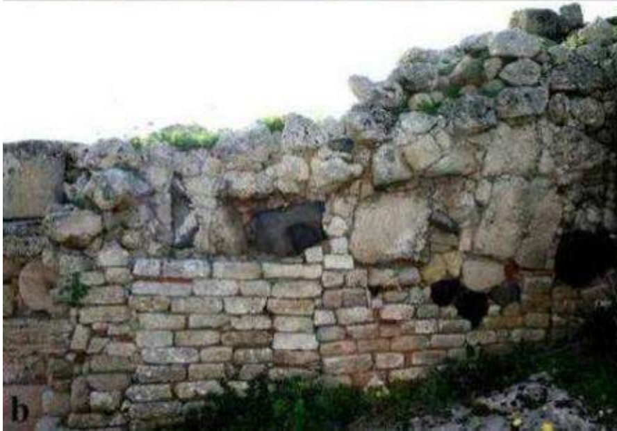
Fig. 174. Vista da Est (a) e da Nord (b) delle murature del complesso n. 70 (foto M. Marano).
