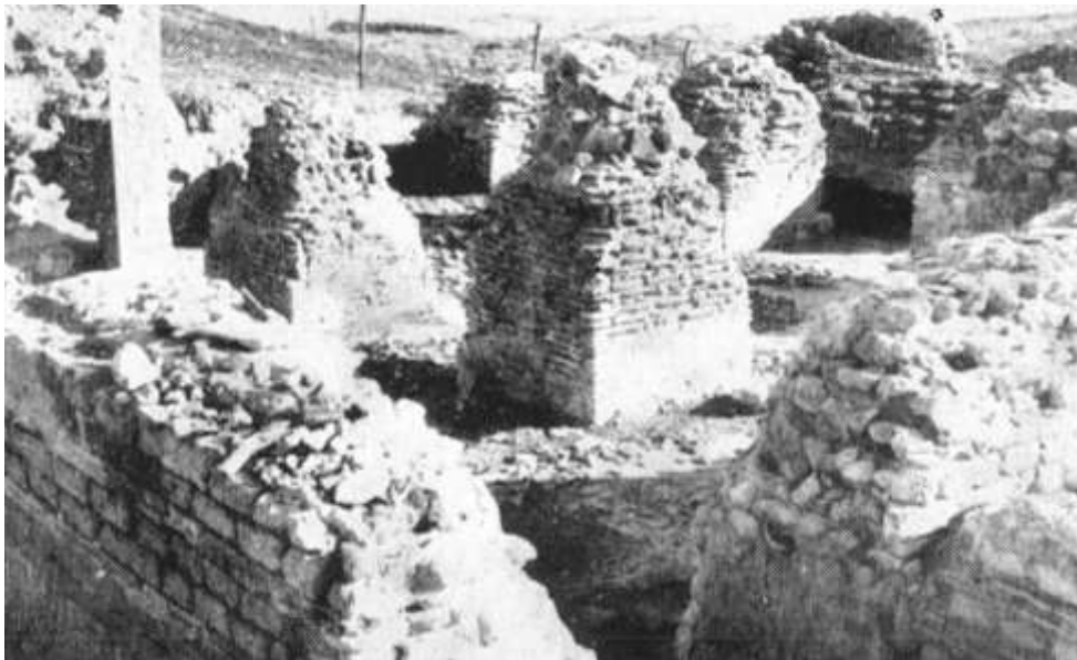
Fig. 10. In basso, ingresso al vano con pilastri del Castellum aquae (PESCE 1958, tav. XI fig. 23).
