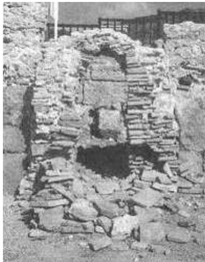
Fig. 140. Crollo di parte del prefurnio delle Terme n. 1 (MORIGI 2004, p. 1198 fig. 5b).
