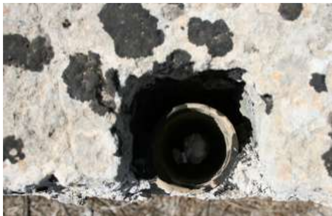
Fig. 44. Dettaglio del tubo in terracotta, visto dall'alto, realizzato all'interno della muratura posta a Ovest della cisterna adiacente al tempio “delle semicolonne doriche” (foto M. Marano).
