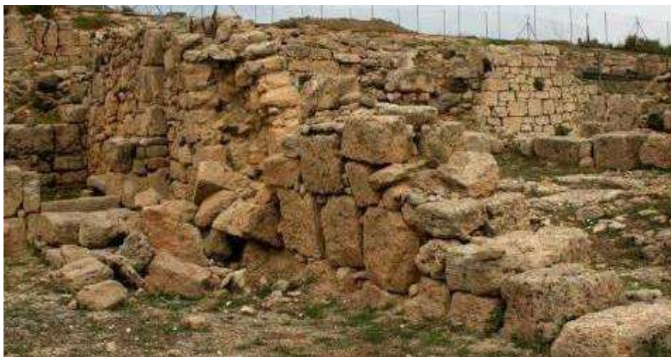
Fig. 141. Crollo di parte della parete settentrionale dell'edificio n. 8 (foto M. Marano).
