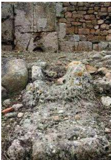
Fig. 151. Vista del tratto di canaletta e del blocco con foro presenti nell'edificio n. 11 (foto M. Marano).
