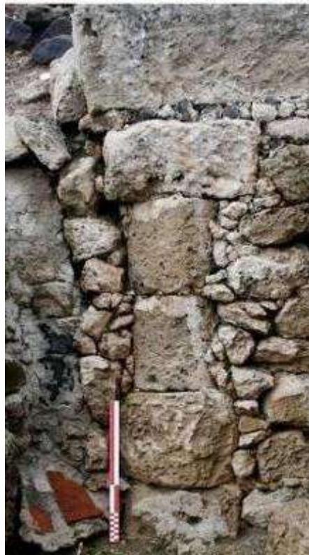
Fig. 170. Vista di un tratto di muro dell'edificio n. 11 (foto M. Marano).
