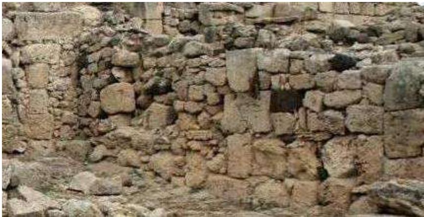
Fig. 231. Vista del tratto di tecnica a telaio delle USM 103-104 e 150 dell'edificio n. V (foto M. Marano).
