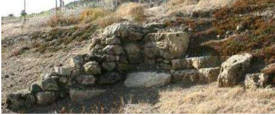
Fig. 191. Vista da Nord-Est degli apparati murari che si interrano sotto la strada moderna, adiacenti all'area contrassegnata con il n. 4 (foto M. Marano).
