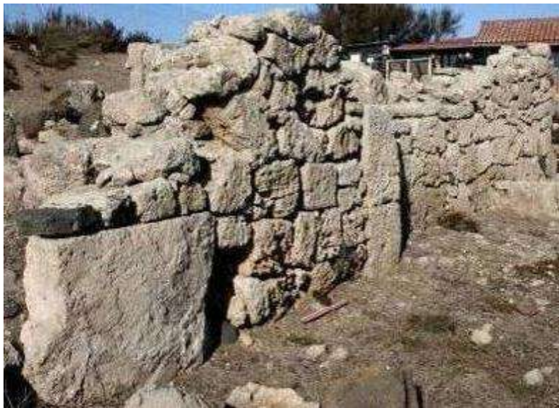
Fig. 201. Vista da Sud-Est dell'apparato murario occidentale (USM 23, 30) che delimita due degli ambienti dell'area n. 3 (foto M. Marano).
