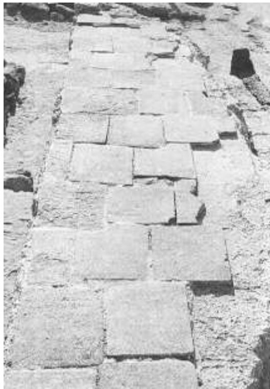
Fig. 7. Particolare della pavimentazione della fontana (indicata nella pianta di scavo con il n. 3) del Castellum aquae (GIORGETTI 1999, p. 154 fig. 13).
