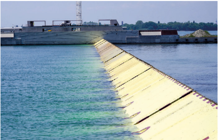
Fig. 2 : Bocca du Lido, projet de Carlo Magnani, sur la culée nord du canal de Treporti. Photo disponible en ligne : www.mosevenezia.eu/my-product/bocca-di-lido/ (dernier accès : 20 mars 2022).
