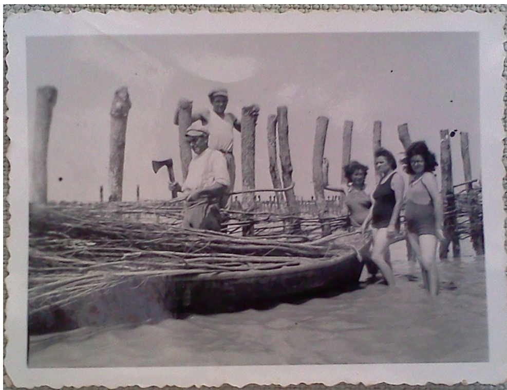
Figure 5. La préparation du clayonnage
