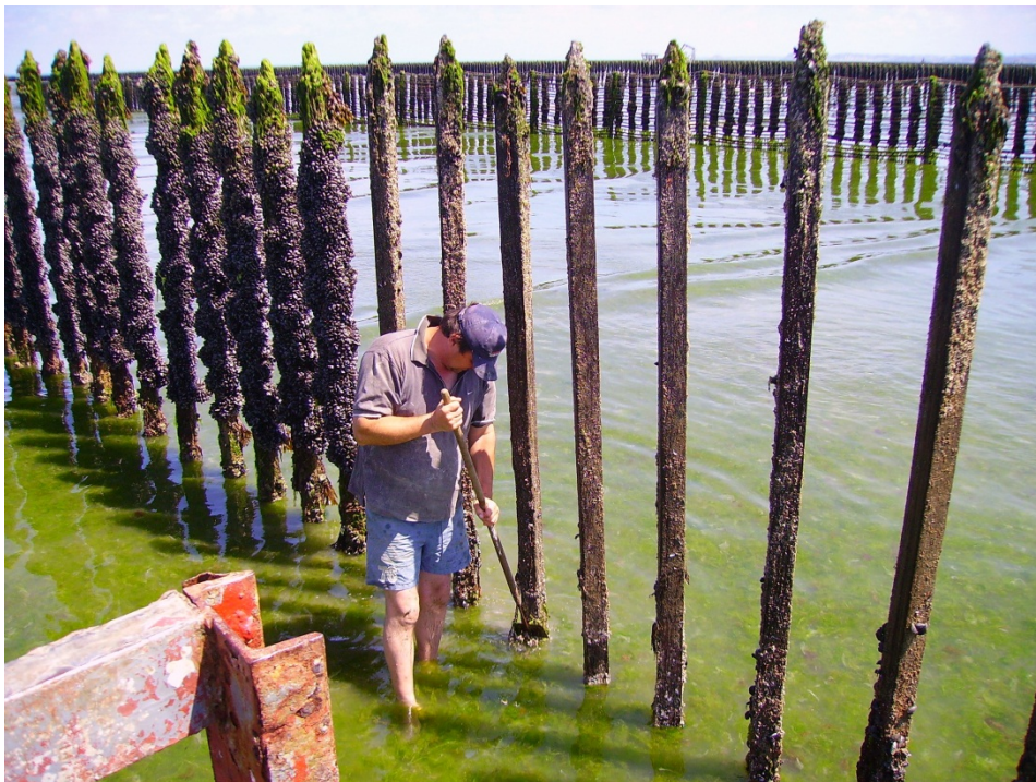
Figure 5. Le grattage des pieux
