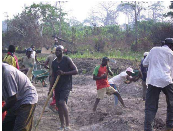
Foto 17. Lavori di realizzazione dei bacini
