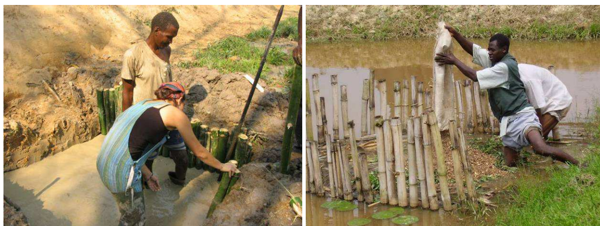
Foto 24 Compostiere: in fase di realizzazione (sinistra) e di riempimento (destra).
