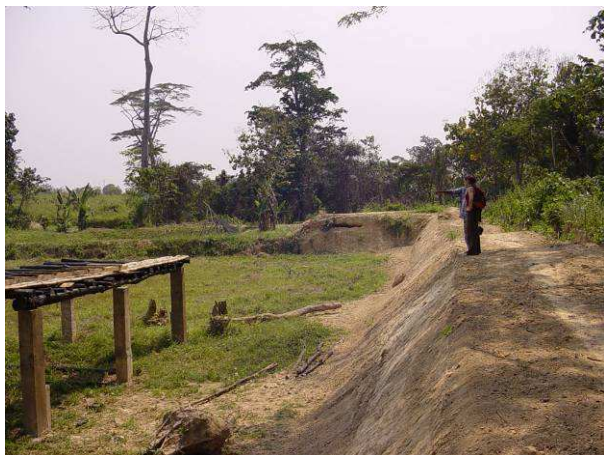
Foto 16 Dighe laterali realizzate con corretta pendenza
