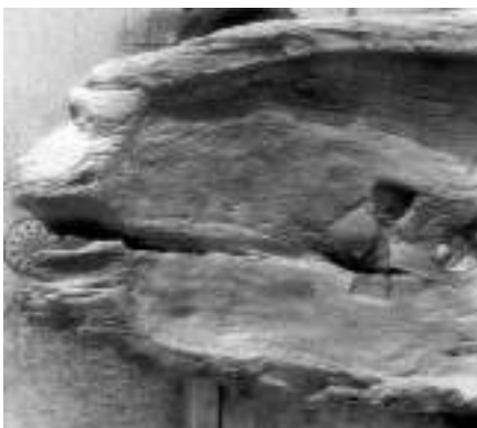
fig.50. incavo per incastro a coda di rondine (ID 66, foto SABAP)
