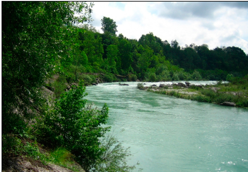
Figura 20: immagine del Fiume Piave presso Ponte nelle Alpi (tratto PIA020). Nella porzione sinistra dell'immagine è possibile osservare la presenza di un'arginatura longitudinale in blocchi di calcestruzzo (sponda destra del fiume).
