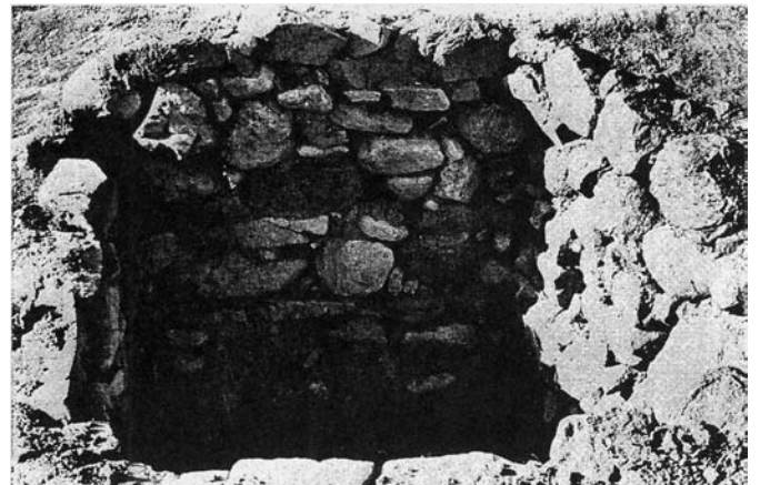
e. Vue de la maçonnerie d'un silo
