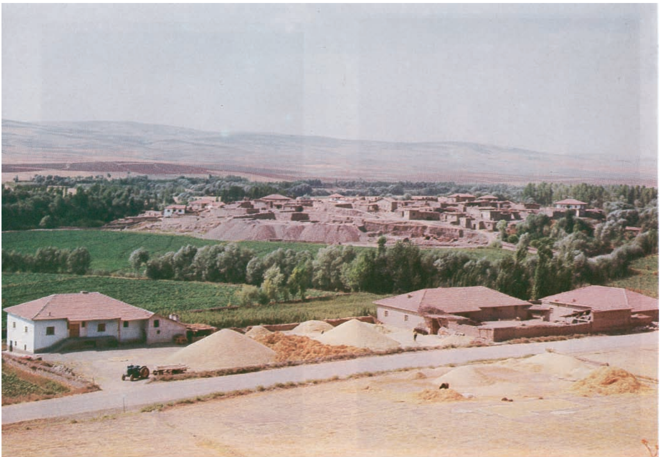
b. Vue du site
